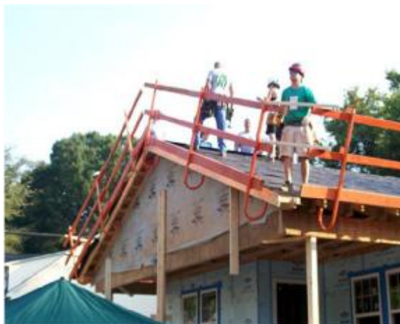
شکل 9- حفاظ گذاری لبه سقف شیب دار
